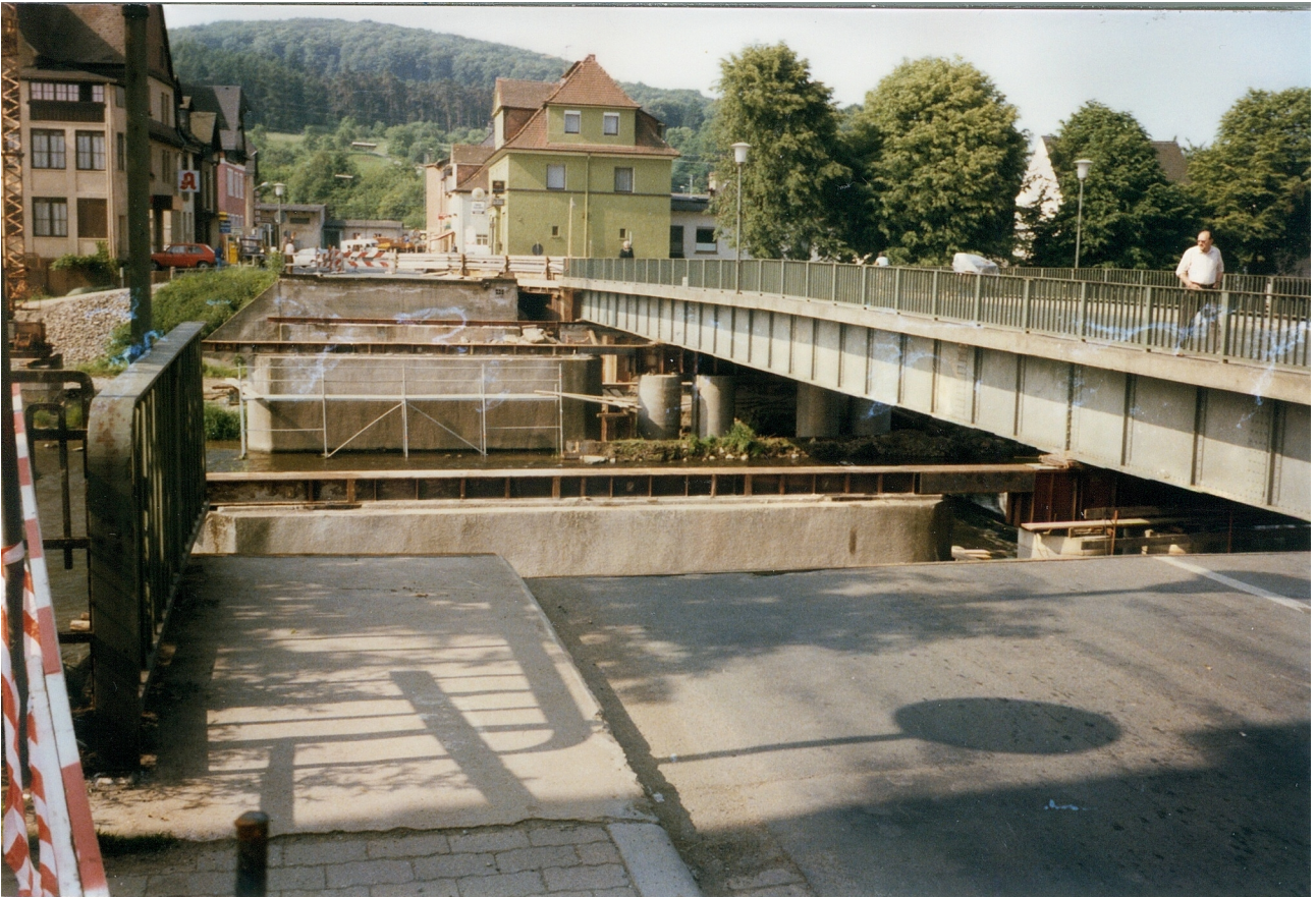
Die Pfeiler der alten Brücke stehen noch, werden in Kürze abgerissen. Über die alte Brücke fließt nun der Verkehr.
