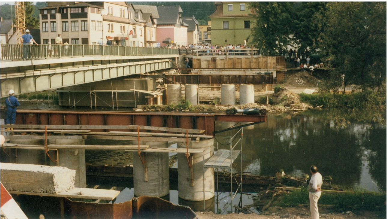
Die provisorischen Pfeiler stehen. Spannung vor der Verschiebung am Freitag, 13.06.1986. Viele Bürger schauen von drüben dem einmaligen Ereignis zu.
