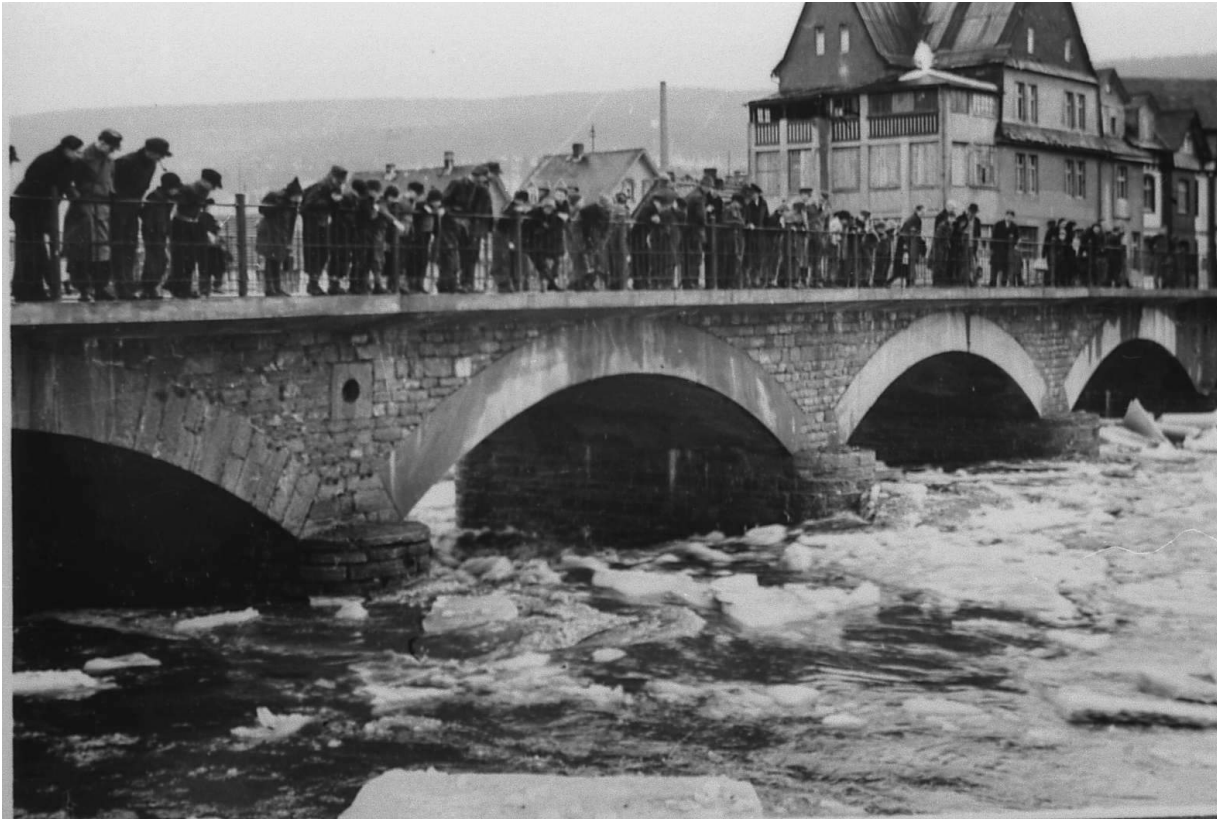
Auf diesem Bild vom März 1947 erkennt man deutlich die im Herbst 1945 aus Beton gegossenen 3 Mittelbögen, während an den äußeren 2 Bögen noch die Bruchsteine vom Neubau der Brücke von 1870/1871 zu erkennen sind.
