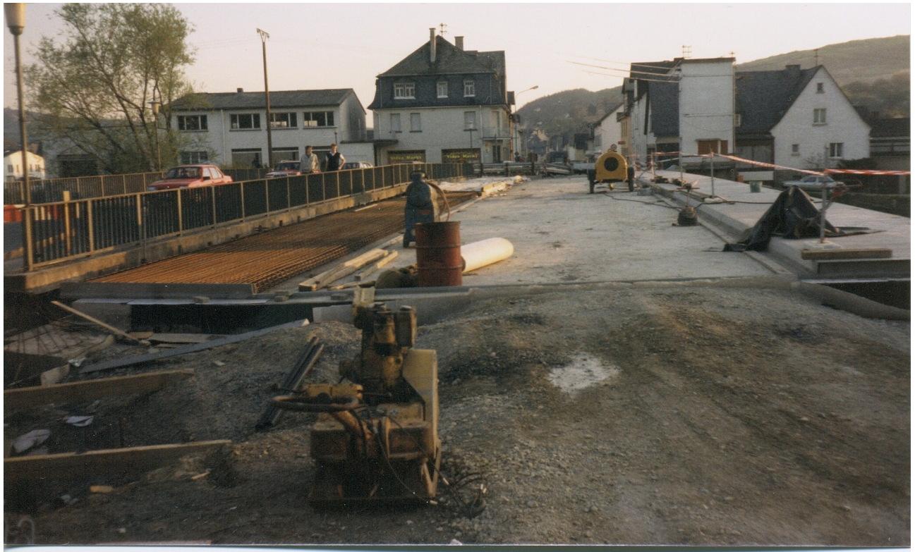
Aufnahme von Anfang Mai 1987: Die Bauarbeiten sind fortgeschritten. Jetzt wird der Bürgersteig der neuen Brücke betoniert. Links sieht man den Verkehr auf der verschobenen Stahlträgerbrücke. Das Gelände ist von der alten Brücke.
