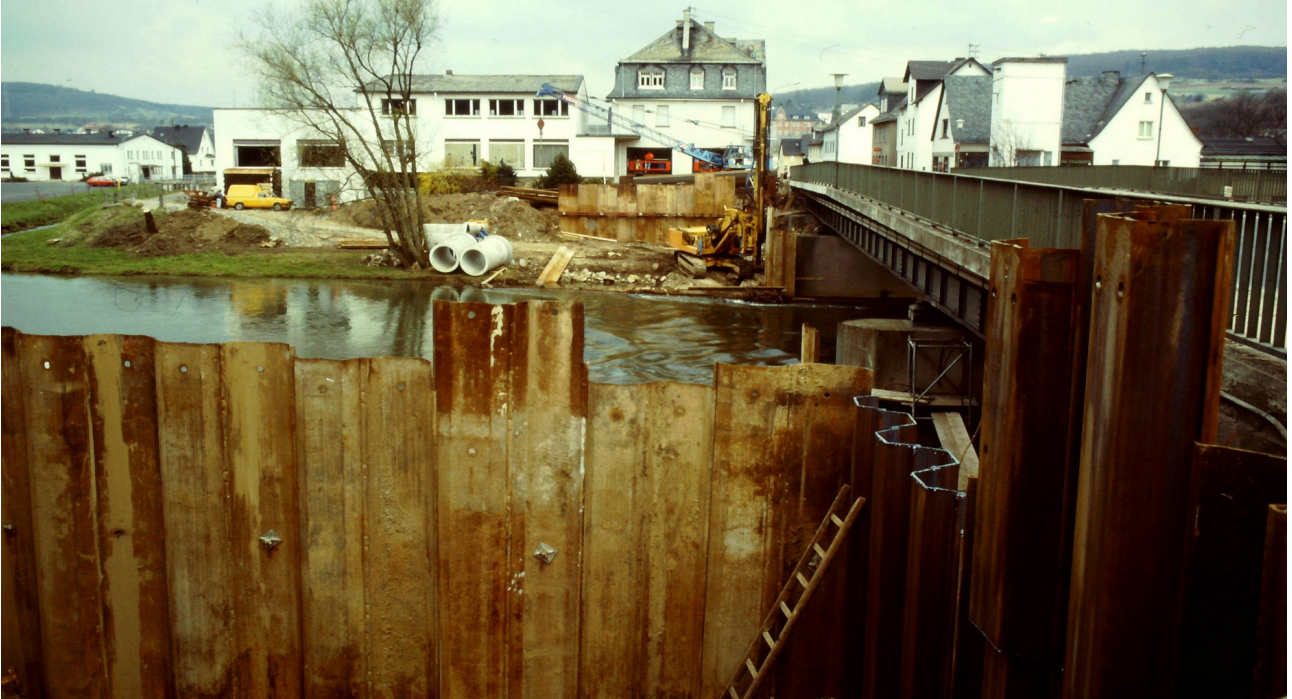
Vorbereitung für provisorische Pfeiler oberhalb der Brücke für die Verschiebung der alten Stahlbrücke als Umleitung.
