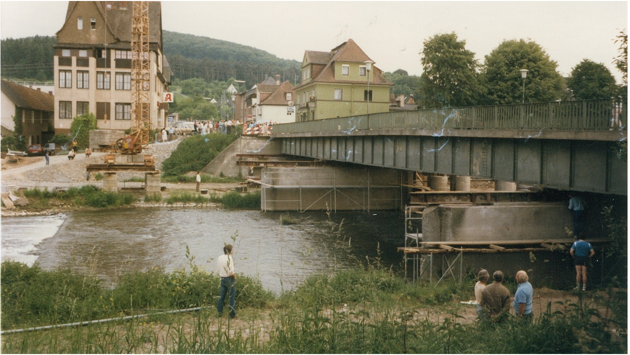
Am Freitag, 13.06.1986, von 19 bis 21 Uhr wird die Stahlbrücke verschoben. Auf dem Bild ist sie jetzt schon halb Fluss aufwärts verschoben.
