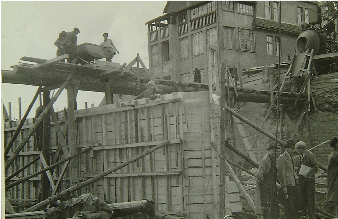
Die neuen Pfeiler werden gebaut.
