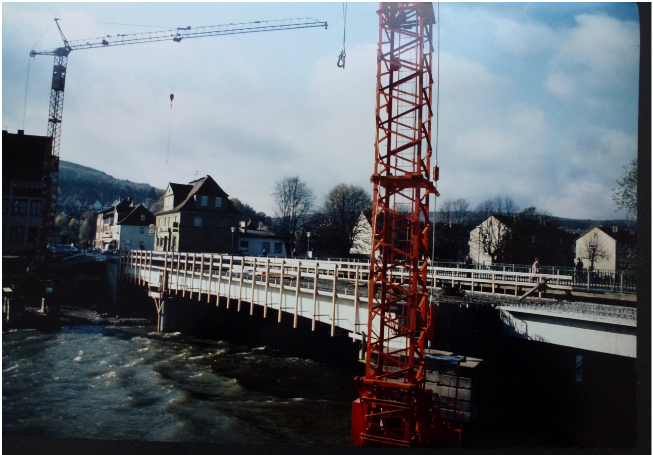
Aufnahme von Anfang Mai 1987: Die Bauarbeiten sind fortgeschritten. Jetzt wird der Bürgersteig der neuen Brücke betoniert. Links sieht man den Verkehr auf der verschobenen Stahlträgerbrücke. Das Gelände ist von der alten Brücke.
