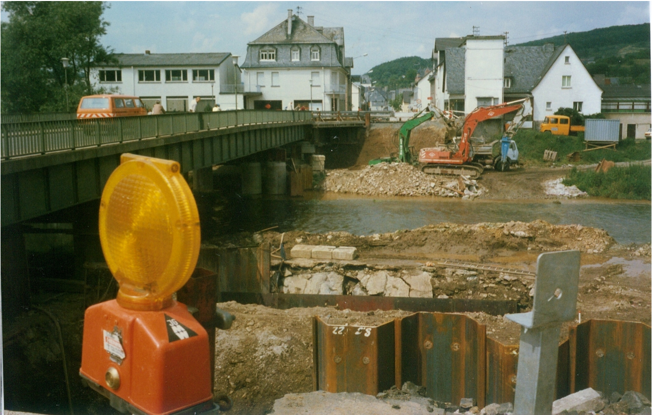
Im Juni 1986 beginnt mit dem Abriss der alten Pfeiler der Neubau.
