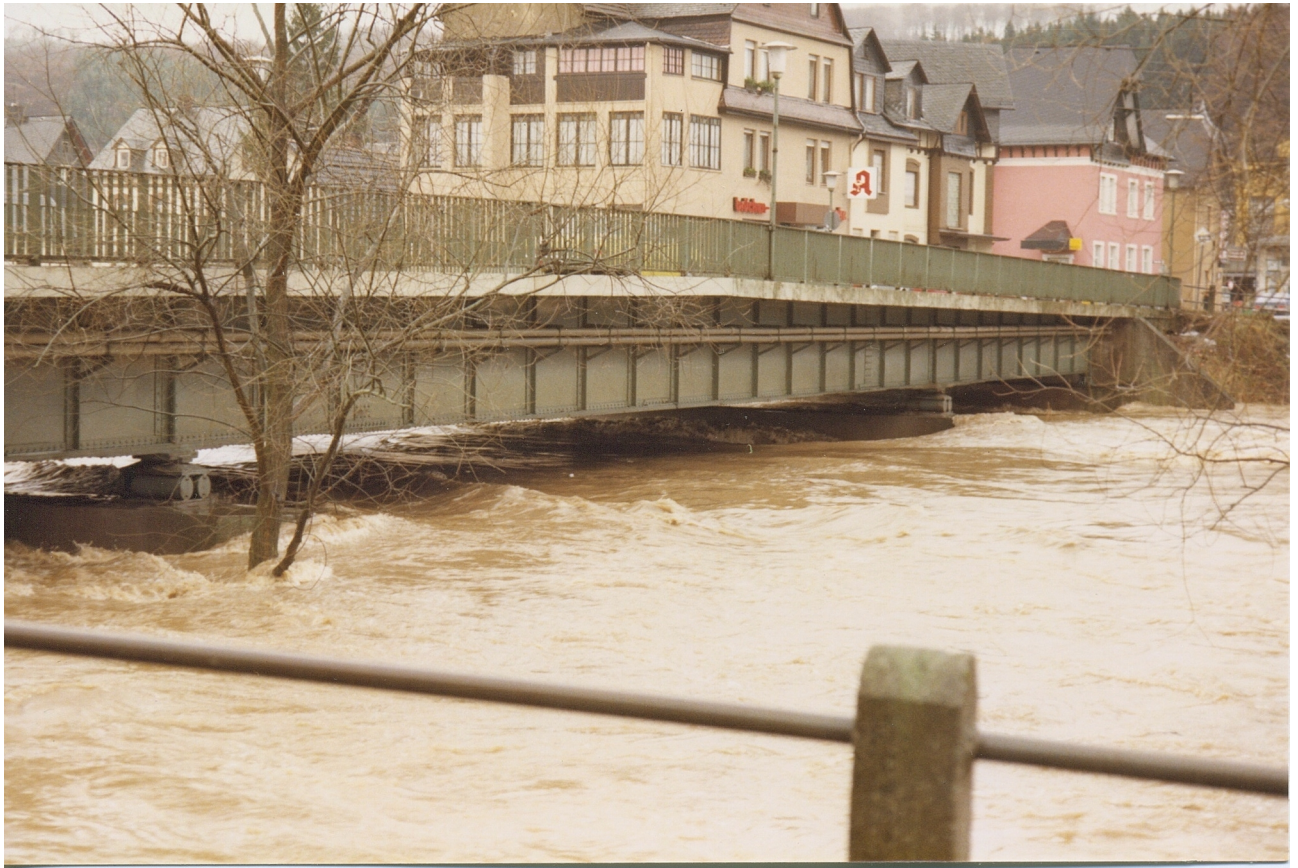
Die Brücke hielt dem Jahrhunderthochwasser im Februar 1984 noch stand.
