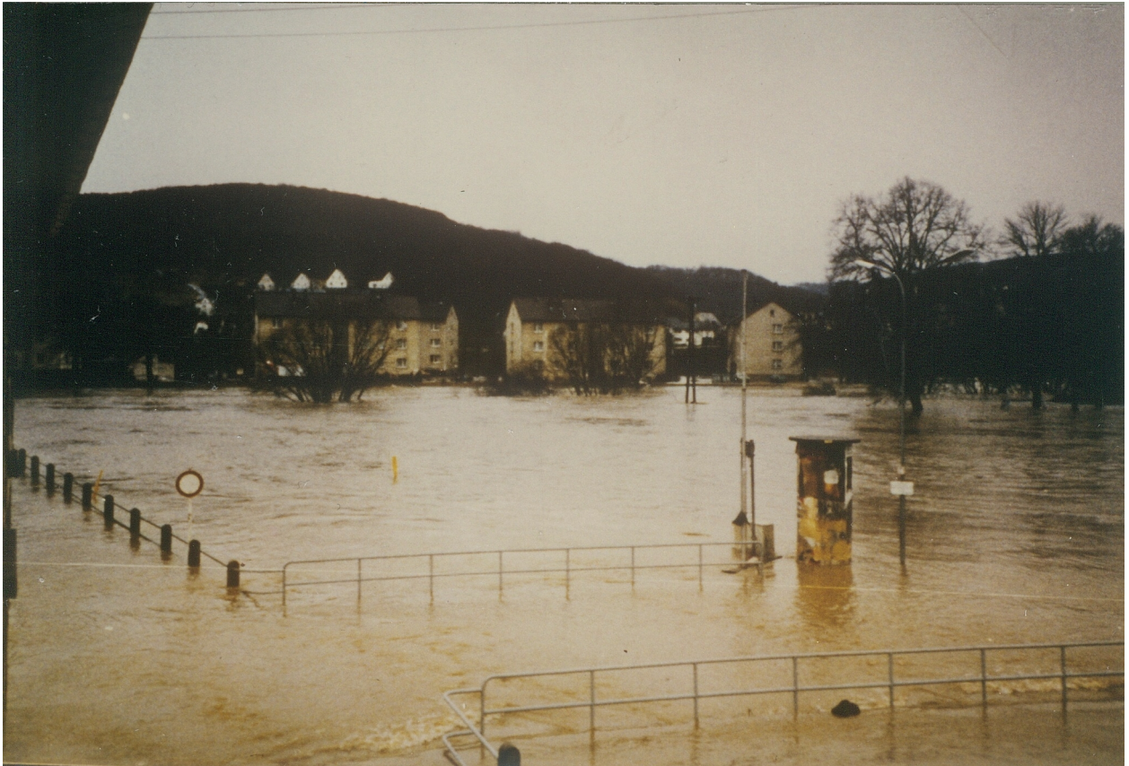
Blick auf die Brücke der Marktstraße und Tuchbleiche am 07.02.1984
