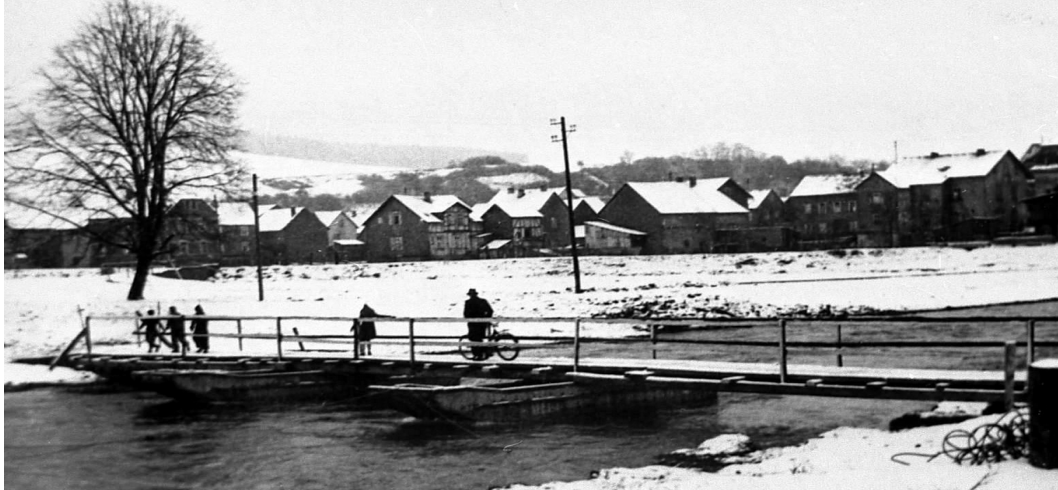
Für Fußgänger wurde 1945 nach dem Einsturz und für die Bauzeit der zwei Pfeiler bis zum Winteranfang oberhalb der Einmündung der Lemp ein Holzsteg gebaut.
