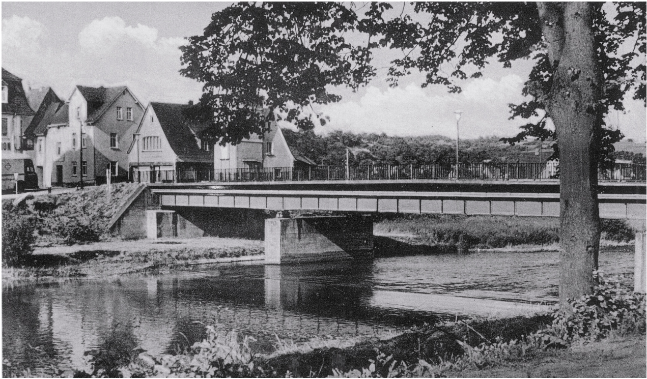
Stahlbrücke hielt von 1949 bis 1986
