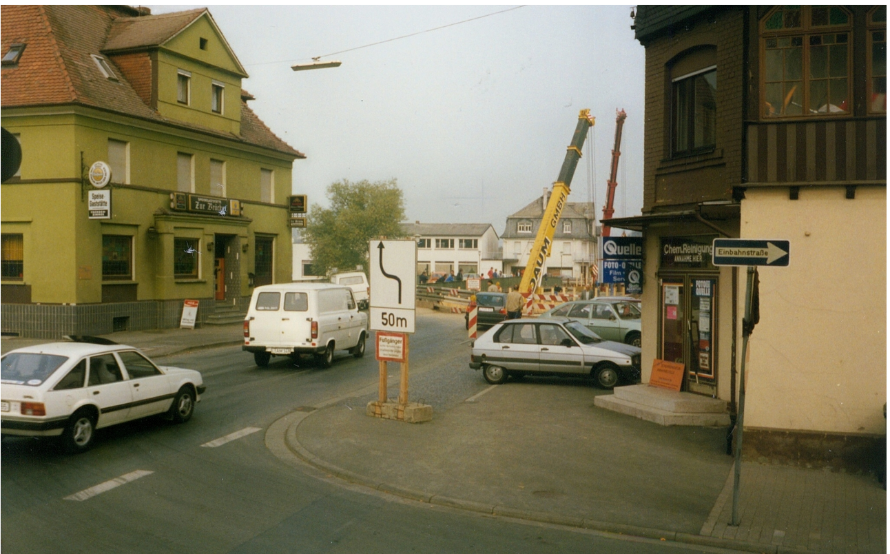
Für die Dauer der Bauzeit diente diese Umleitung für einen flüssigen Verkehr. Es kam zu keinen Behinderungen oder Warteschlangen.
