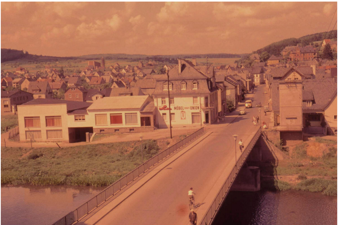
Brücke mit Bahnhofstraße und der Firma Möbel Union Schulte, ca.1960
