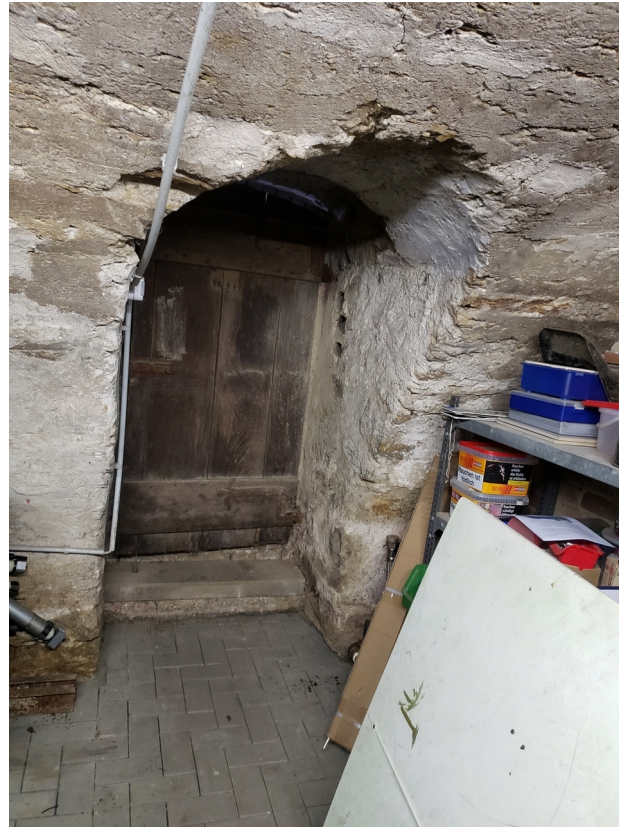
Kellereingang, hier sieht man die Dicke des Gewölbekellers
