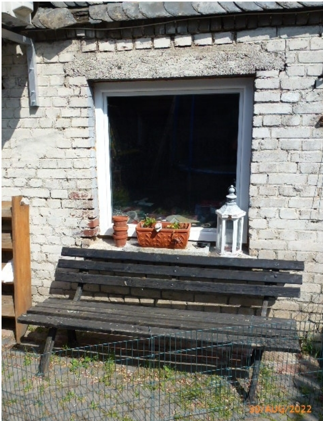
Fenster der Waschküche
