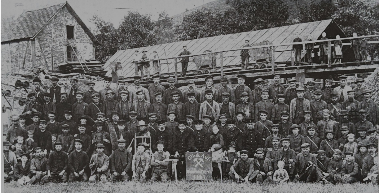
Scheideanlage gegenüber dem Georgsstollen, Bild von 1887, li. die Körbe der 1. Seilbahn
