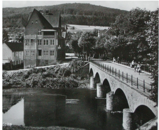
Neue Brücke mit der Baumreihe (hinten)
