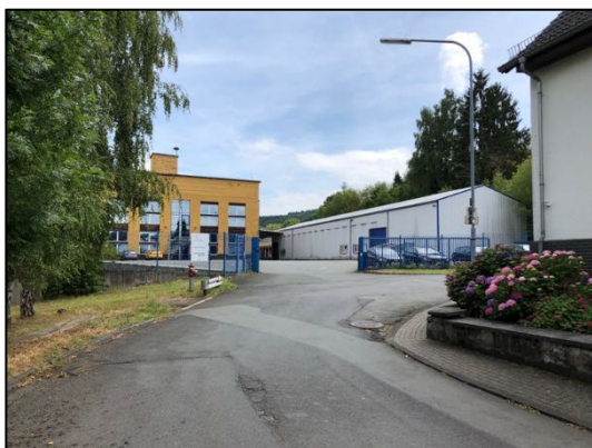
Abbildung 5: Zufahrt in das Plangebiet
