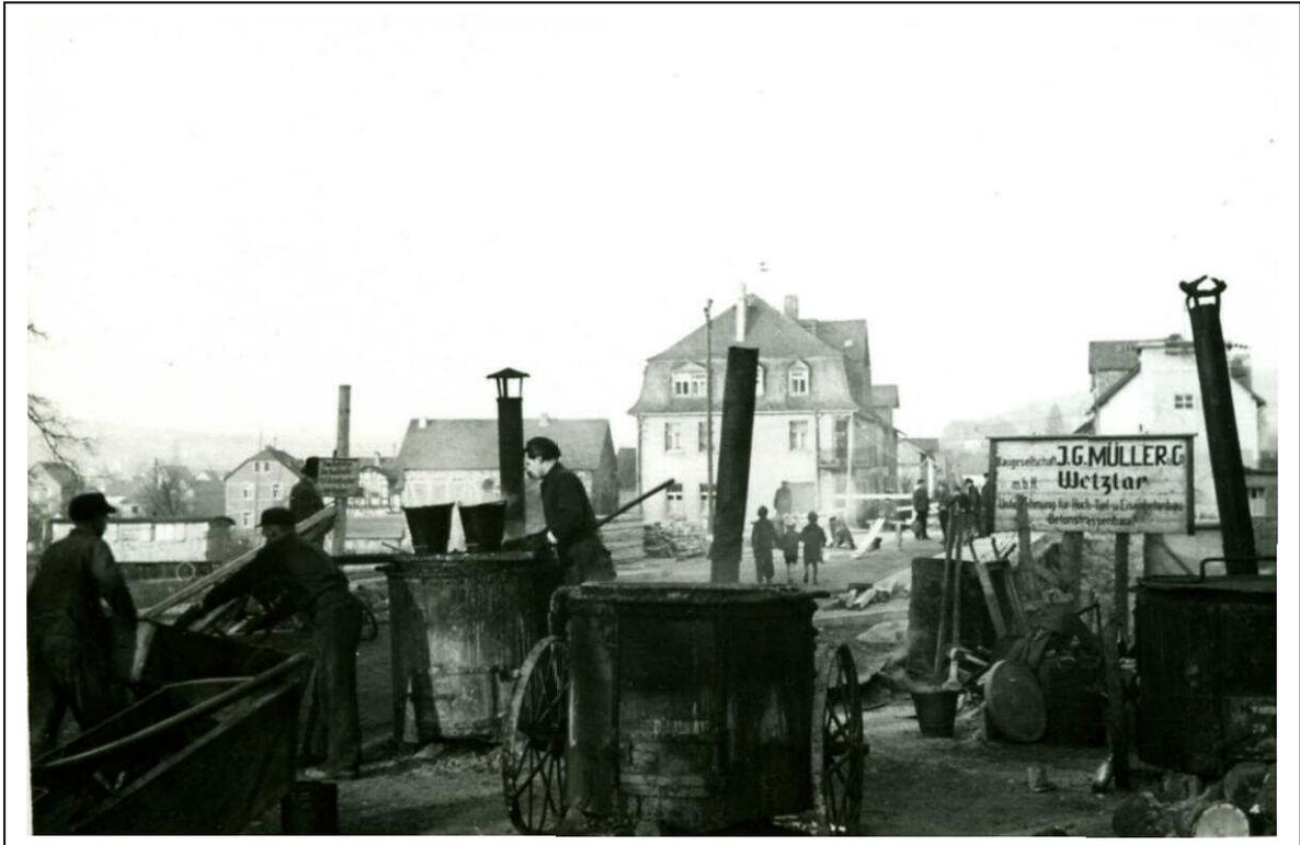
Beschleunigt durch die Währungsreform am 20.06.1948 konnte im Spätherbst die Fahrbahn mit Bürgersteig betoniert werden. Mangels Maschine musste die letzte Teerschicht noch in Handarbeit aufgetragen werden.
